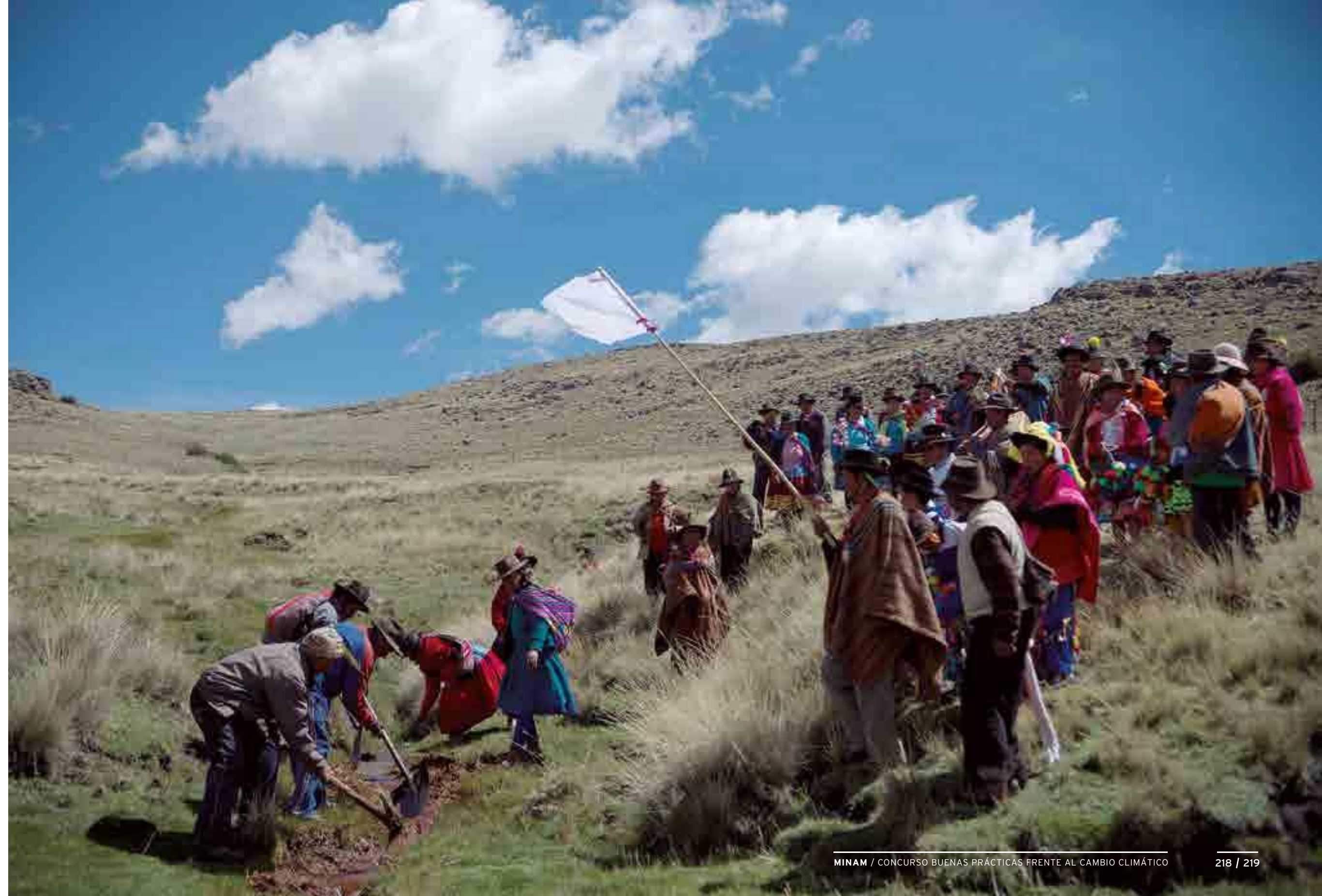
► Comuneros retiran con azadas los sedimentos que impiden que fluya el agua del puquio Ccelloquera, en las alturas de San Miguel de Cchechepampa.
